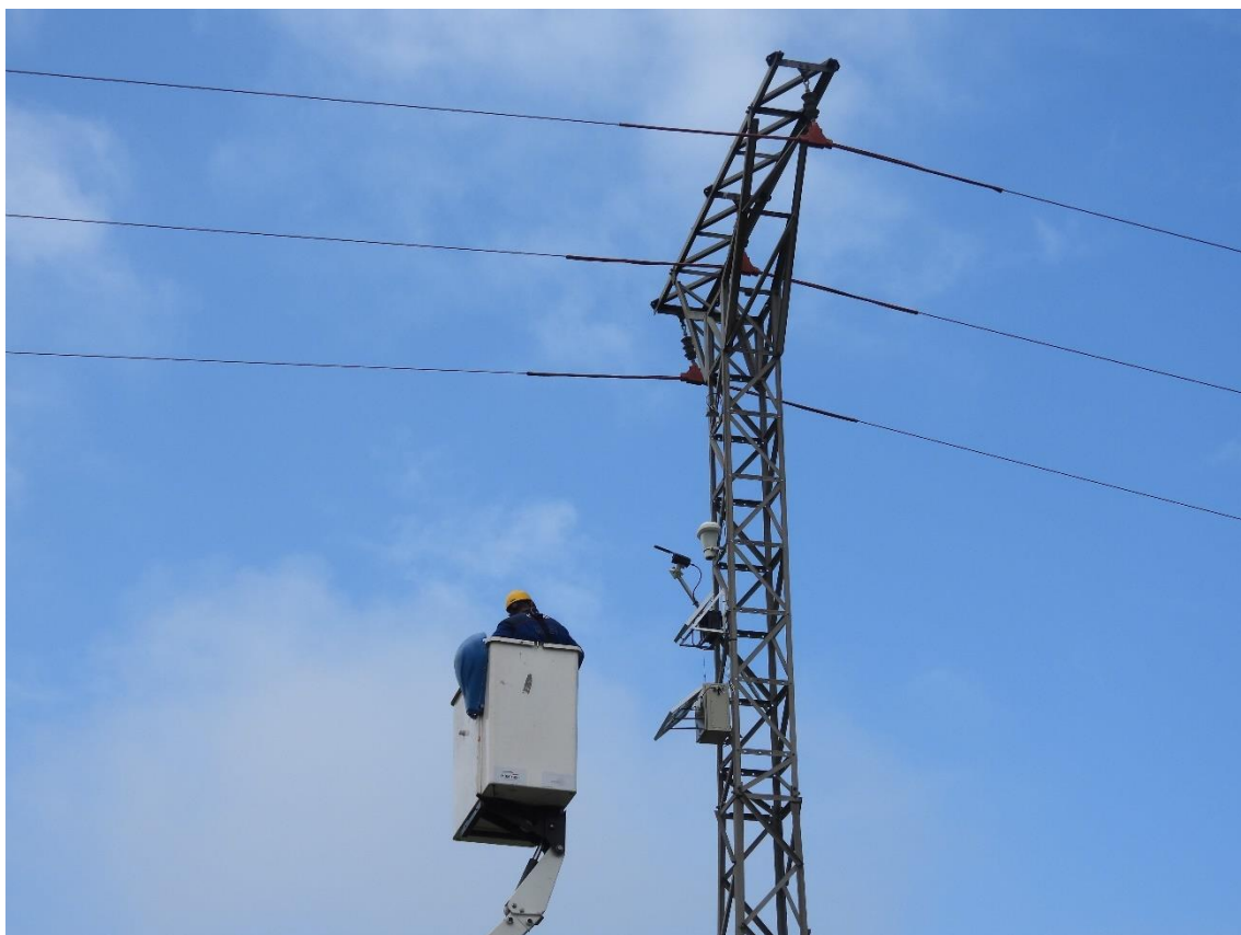
Fig. 128: Colocación de uno de los 5 dispositivos antiposada en el área de reintroducción.
