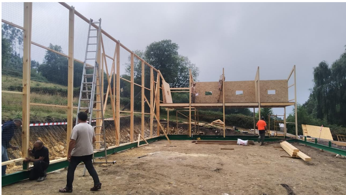
Fig.84: Vista de la jaula de hacking-aclimatación durante su construcción en 2021.
