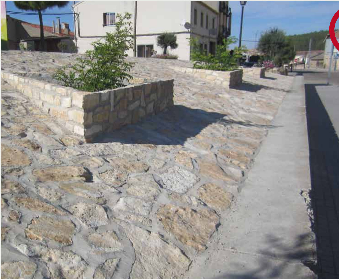
Poyete de hormigón y empedrado de talud con juntas selladas, entre parque urbano y acera.
