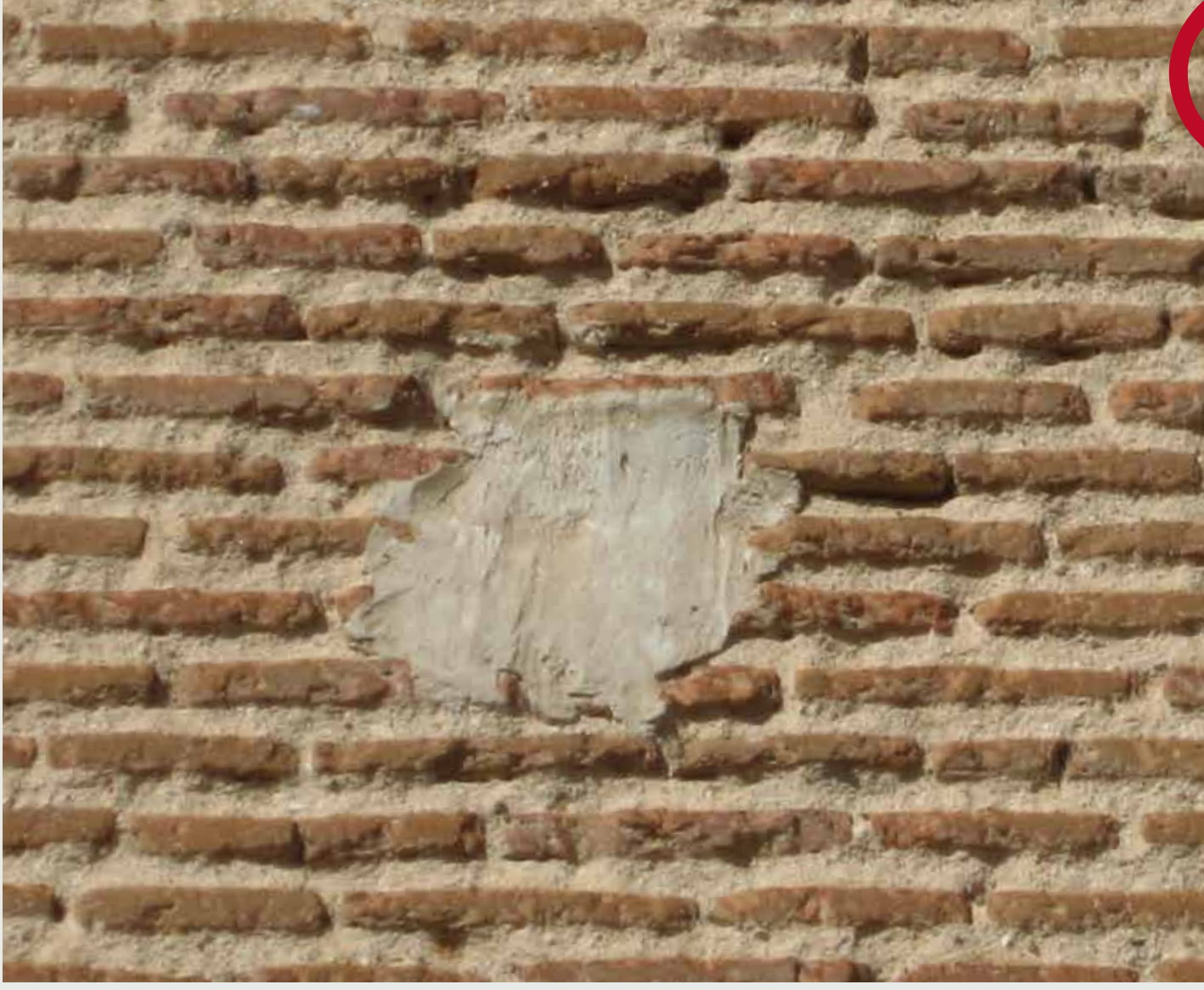
Mechinal tapado con pegote de cemento desluce un edificio patrimonial.
