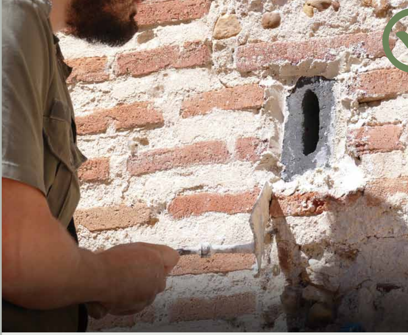
Instalación de placa-nido para murciélagos que impide nidificar palomas en mechinales de edificios históricos.
