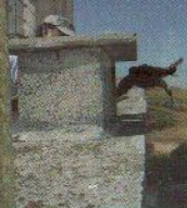
Nidal de hormigón en silo
